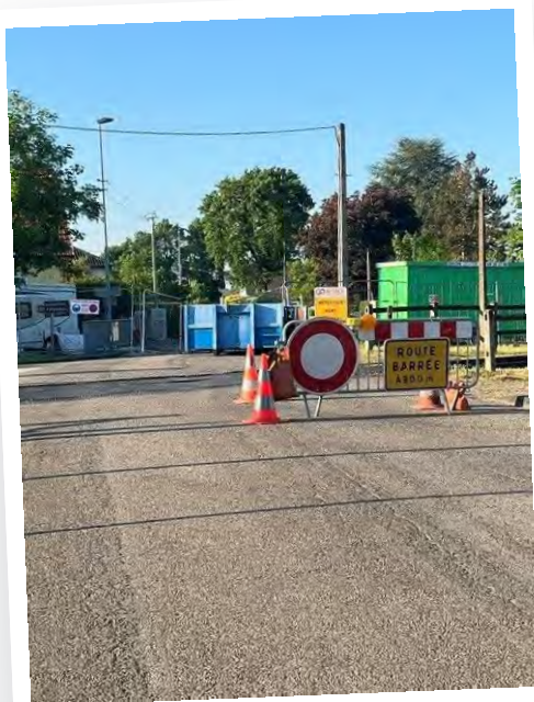
Rue de Sessenheim : rénovation de l'ouvrage d'art du Fallgraben.
